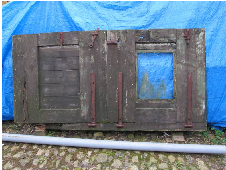
De eerder in de linker zijgevel van het noordelijke bouwdeel aanwezige deur.
