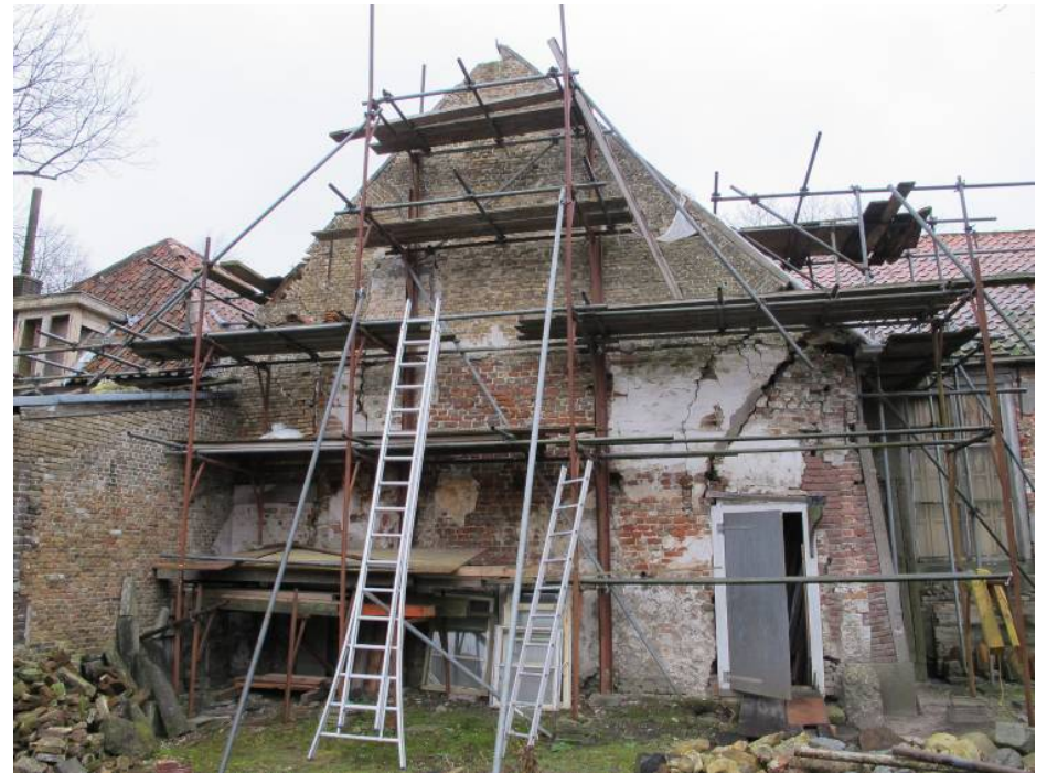
Overzicht achtergevel noordelijk bouwdeel
