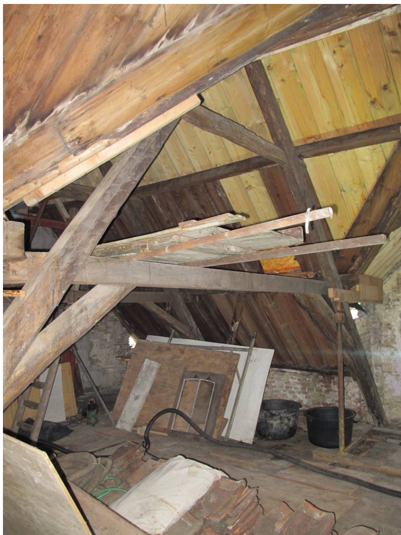
Overzicht van de constructie boven het noordelijke bouwdeel, gezien in noordwestelijke richting.
