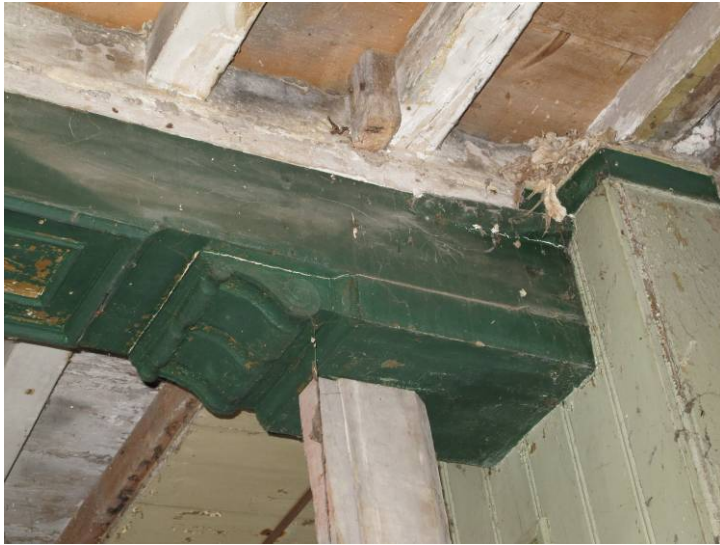
Detail van één van de onder de moerbalken aanwezige consoles.
