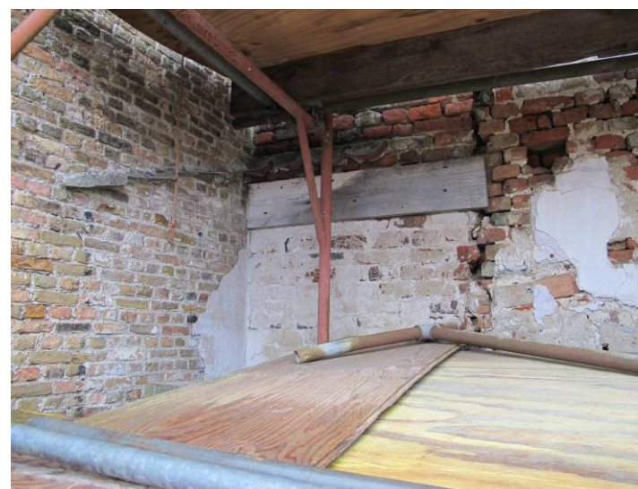
Bovenste deel van een dichtzetting aan de noordzijde van de achtergevel.
