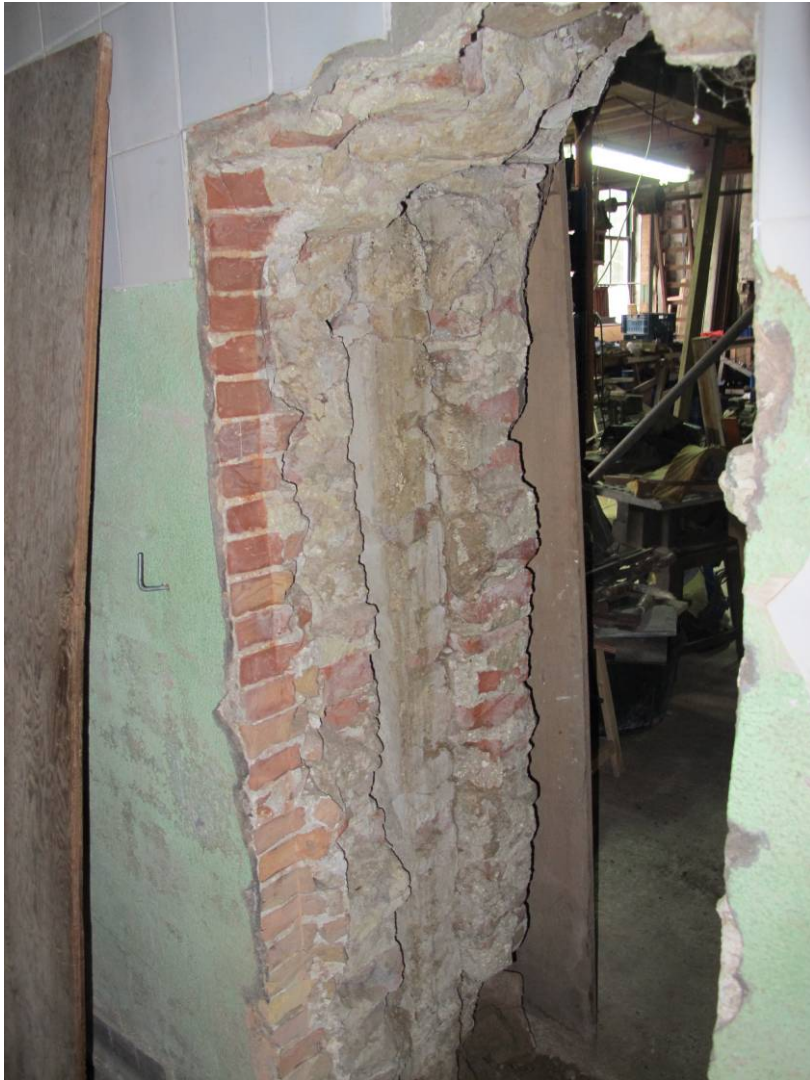
Meerschalgige opbouw van de noordelijke zijgevel aan de oostzijde van de doorgang naar het buurpand. Aan deze zijde is een spouw met gepleisterde afwerking zichtbaar.
