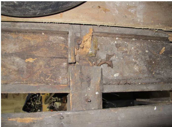
Detail van de aansluiting van de kinderbinten op de moerbalk.
