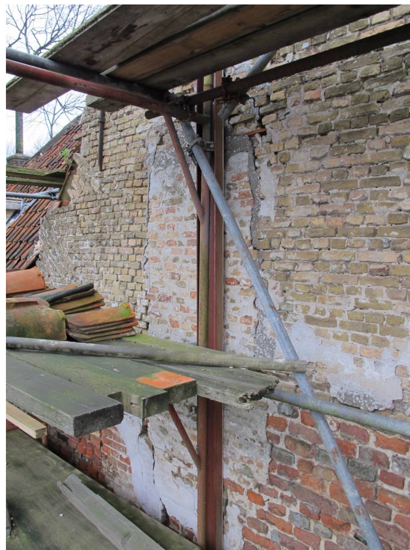
Dichtgemetselde luikopening op de verdieping van de achtergevel.
