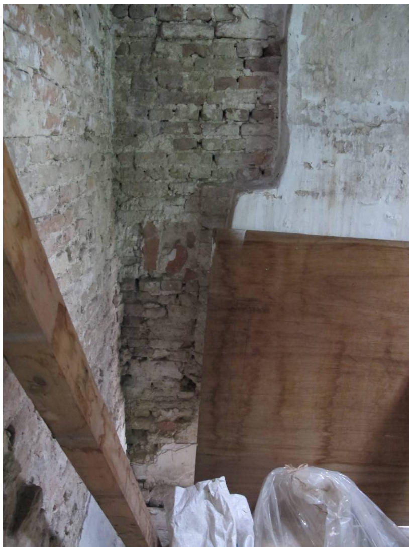
Sporen van omvorming van een topgevel tot de huidige lijstgevel bij de aansluiting op de rechter zijgevel (links). Het ongepleisterde deel behoort bij omvorming tot de huidige lijstgevelopzet.
