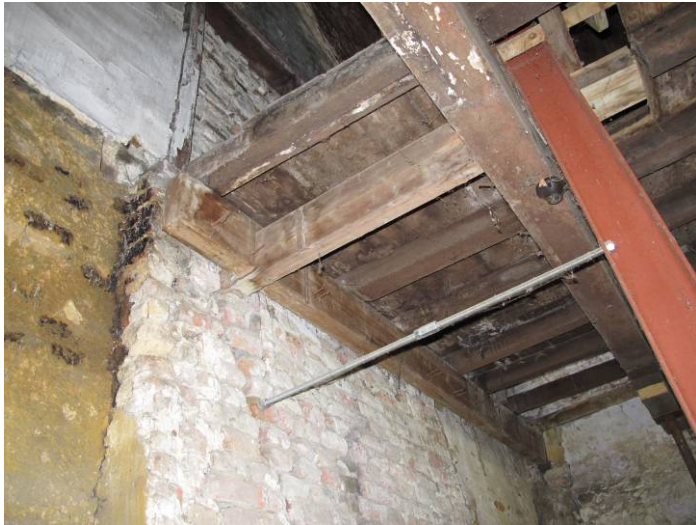
Extra ondersteuning van de kinderbinten bij de achtergevel. Links is nog een hoek van de stookplaats zichtbaar.
