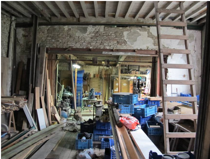
Zicht op de bouwmuur tussen beide bouwdeelen, gezien vanaf de zuidzijde.
