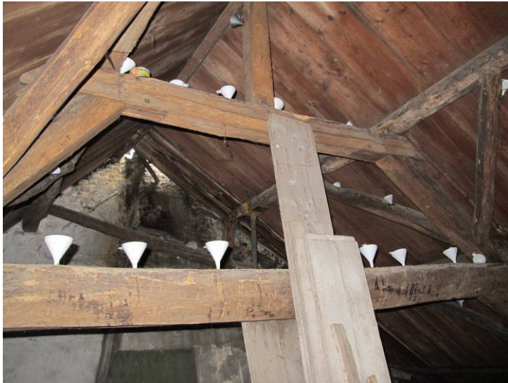
Overzicht van het zuidelijke stapeljuk.
