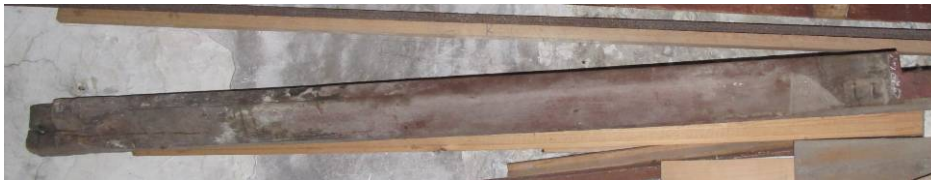
Detail van een door dhr. Bruijns aangetroffen, als kinderbint hergebruikte kozijnstijl van een kruiskozijn. Of dit onderdeel ook daadwerkelijk heeft toebehoord aan een venster van het onderzochte pand valt niet te achterhalen.
