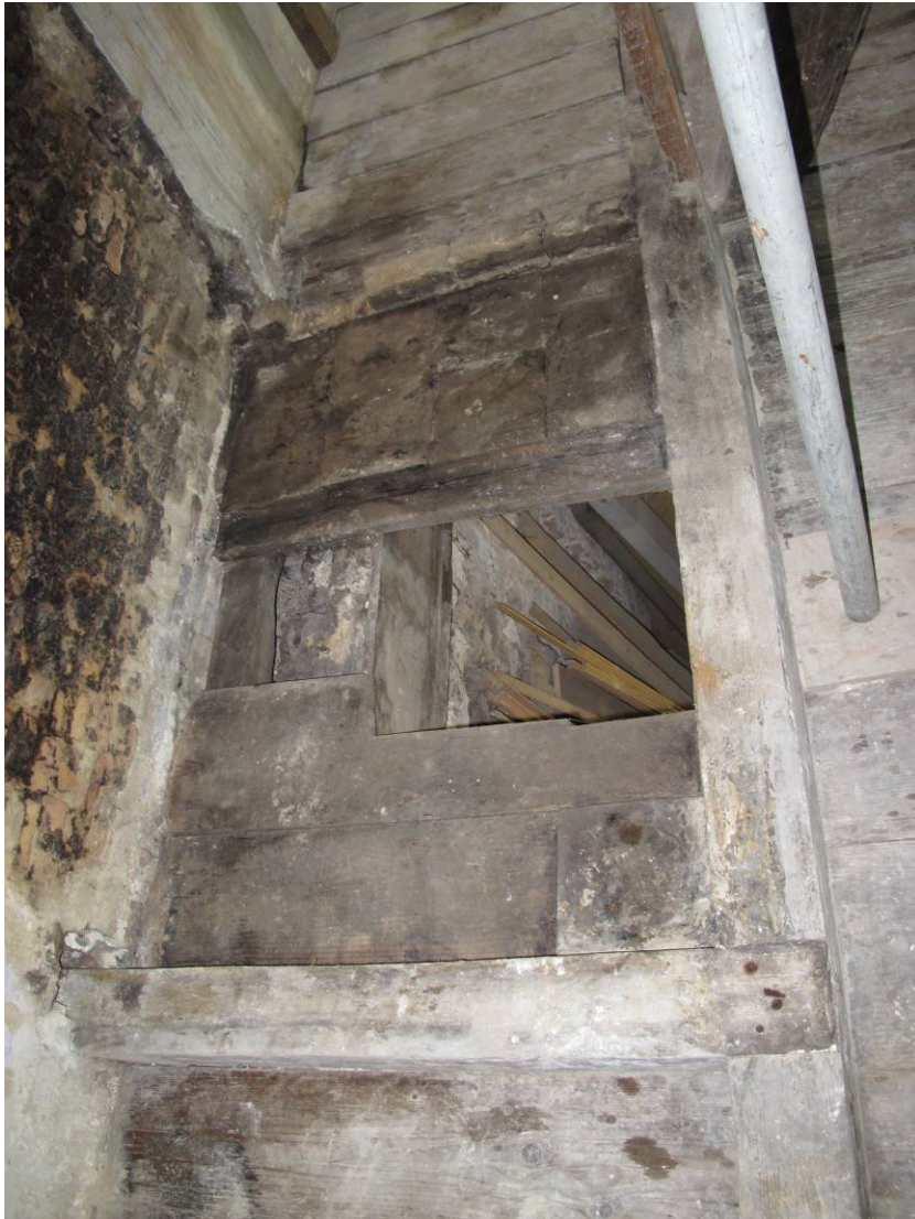
De onderslag van het gesloopte rookkanaal tegen de noordgevel. Op de vloerdelen liggen plavuizen.
