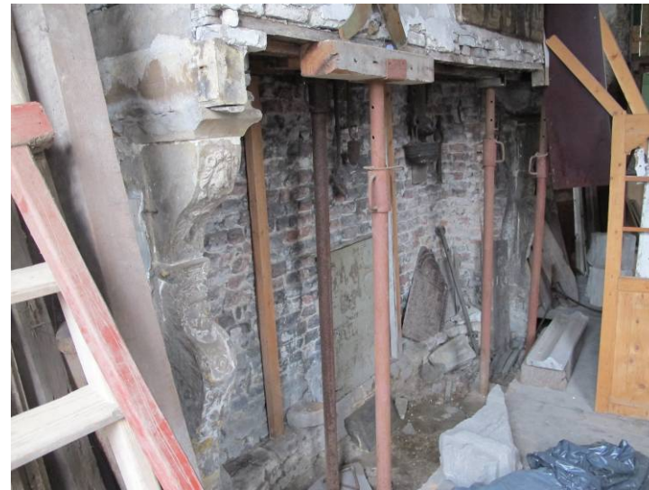
Overzicht van de stookplaats tegen de zuidgevel.
