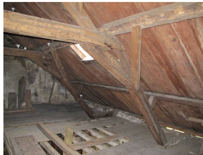
De zeer schuin geplaatste spantbenen onder het achterschild.
