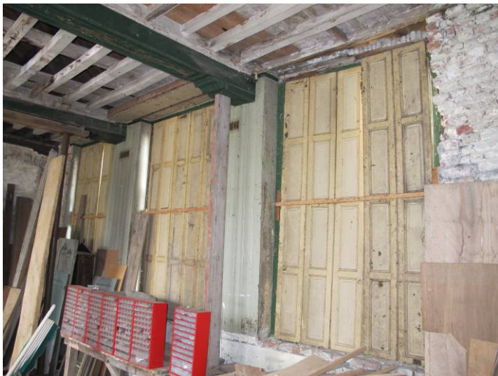
Overzicht van de achtergevel. De vensters hebben binnenluiken.
