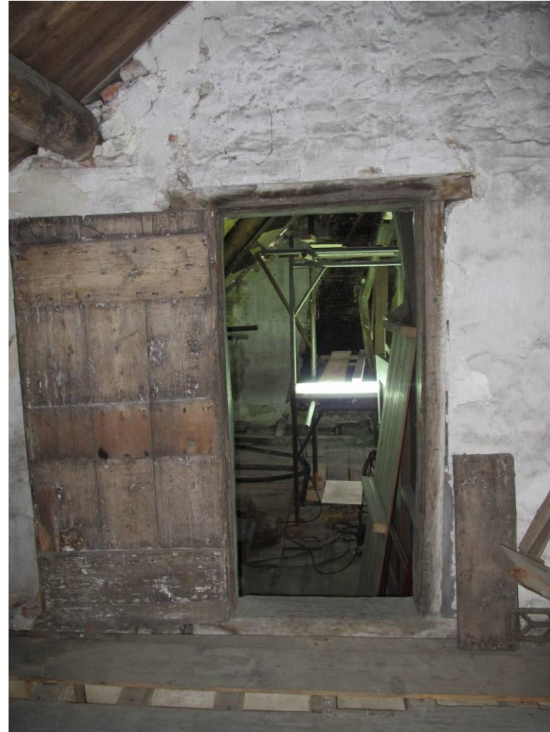
Kozijn met opgeklampte deur in bouwmuur tussen bouwdelen.
