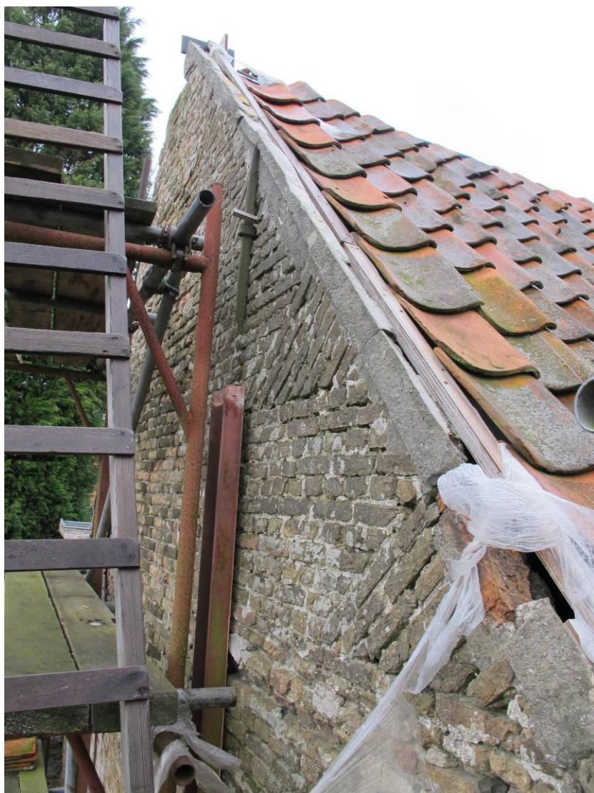
Detail van de geveltop met onregelmatige vlechtingen langs de rand.
