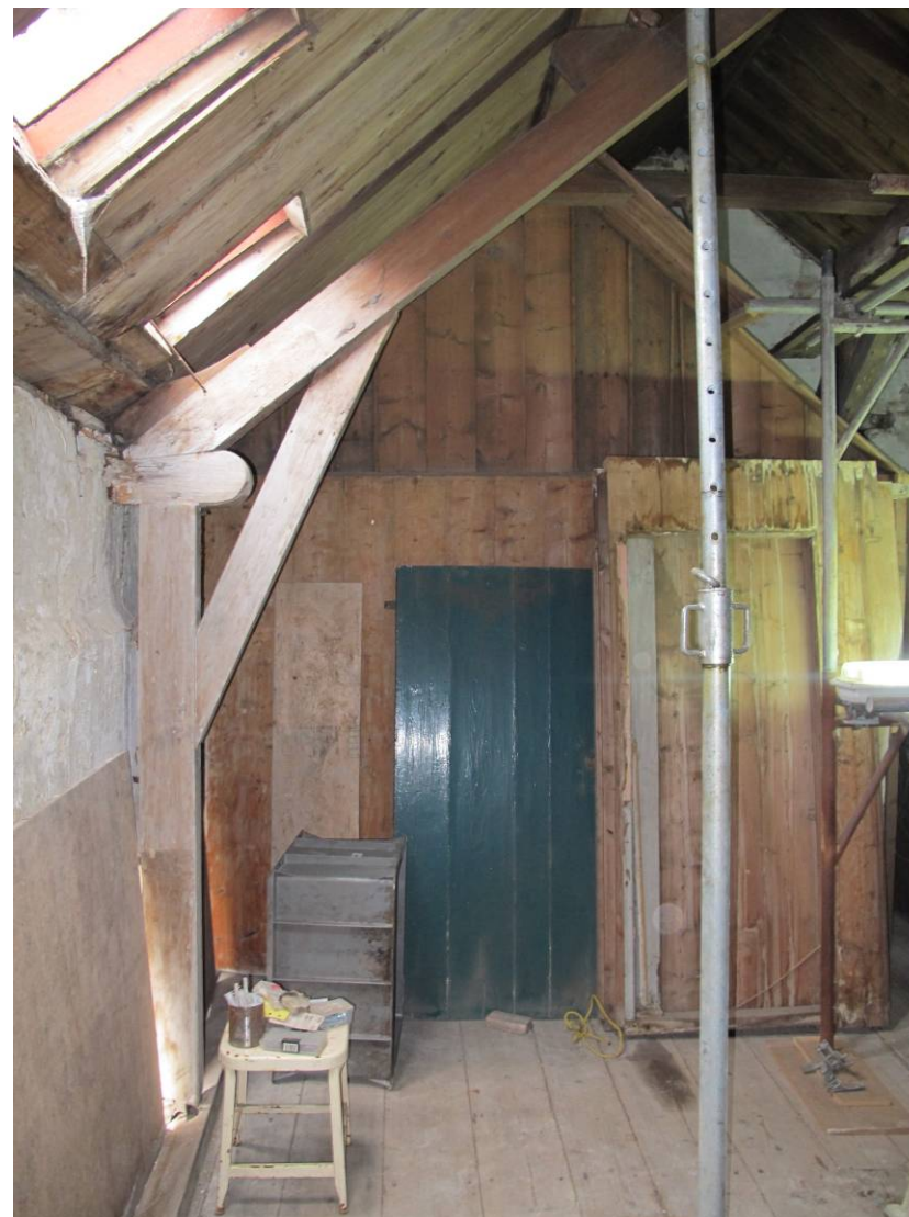
Recht spantbeen tegen voorgevel ter hoogte van de nok van de langskap.
