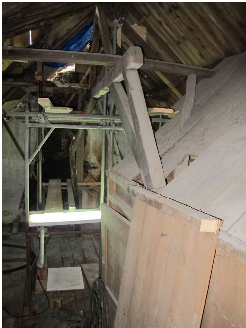
Het afwijkende voorste spant staat onder de nok van de dwarskap.
