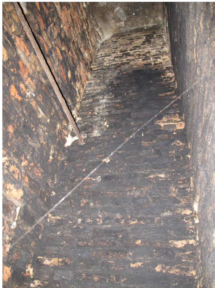
Binnenzijde rookkanaal, met links de zuidelijke topgevel.
