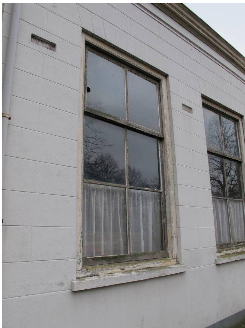
Detail van de vensters in het linker deel van de voorgevel. De kozijnen hebben een kraalprofiel.
