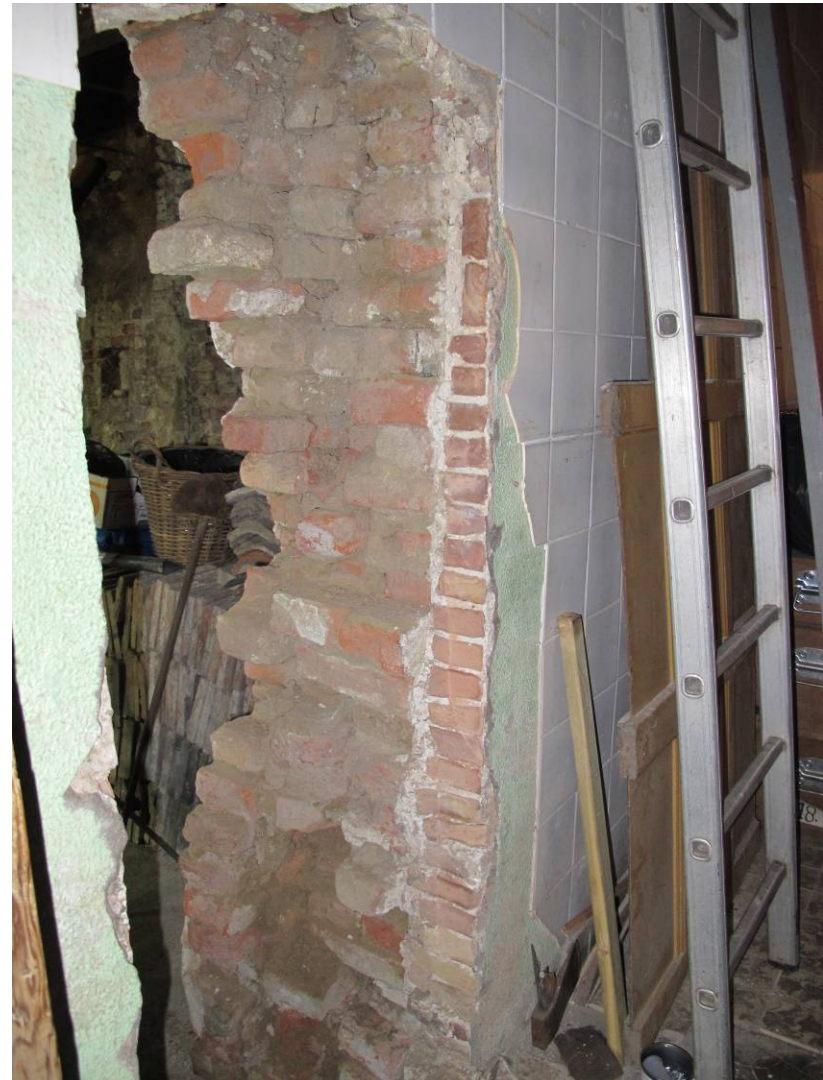
Opbouw van de noordelijke zijgevel aan de westzijde van de doorbraak. Hier is anderhalfsteens muurwerk in hergebruikte baksteen zichtbaar, met aan de zijde van het buurpand een halfsteens klamp.
