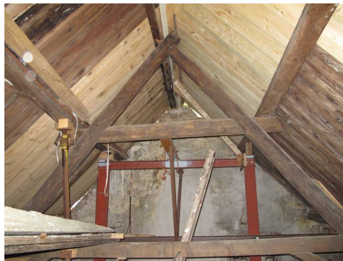
Bovenzijde constructie bij aansluiting achtergevel.
