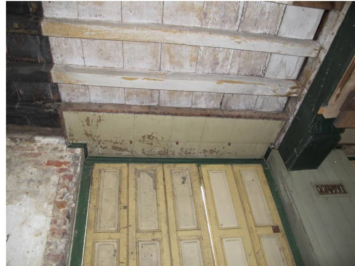
Restant van een vlak houten plafond boven één van de vensters.
