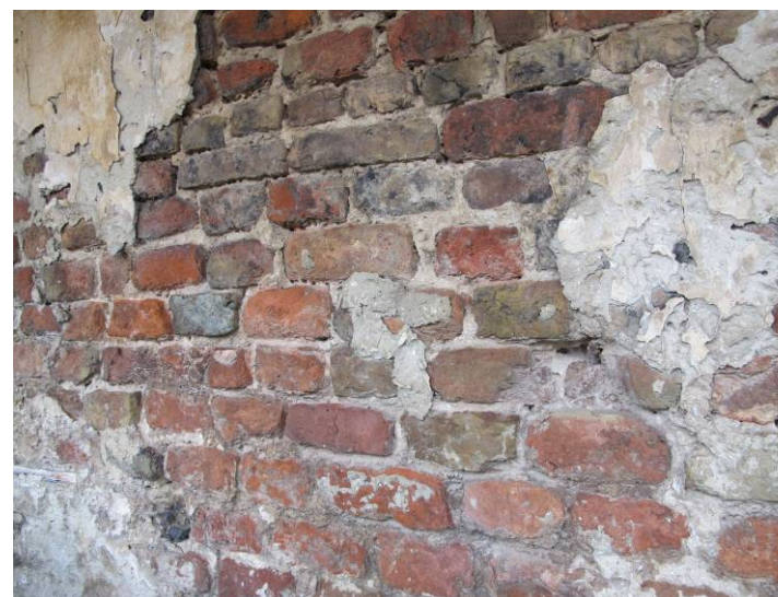
Detail van het in hergebruikte steen uitgevoerde muurwerk van de achtergevel.
