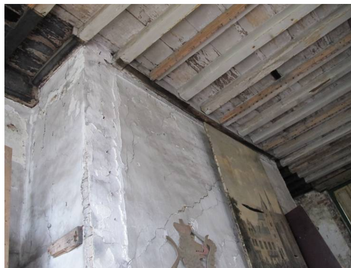
De rechte gemetselde boezem van de stookplaats tegen de zuidgevel.
