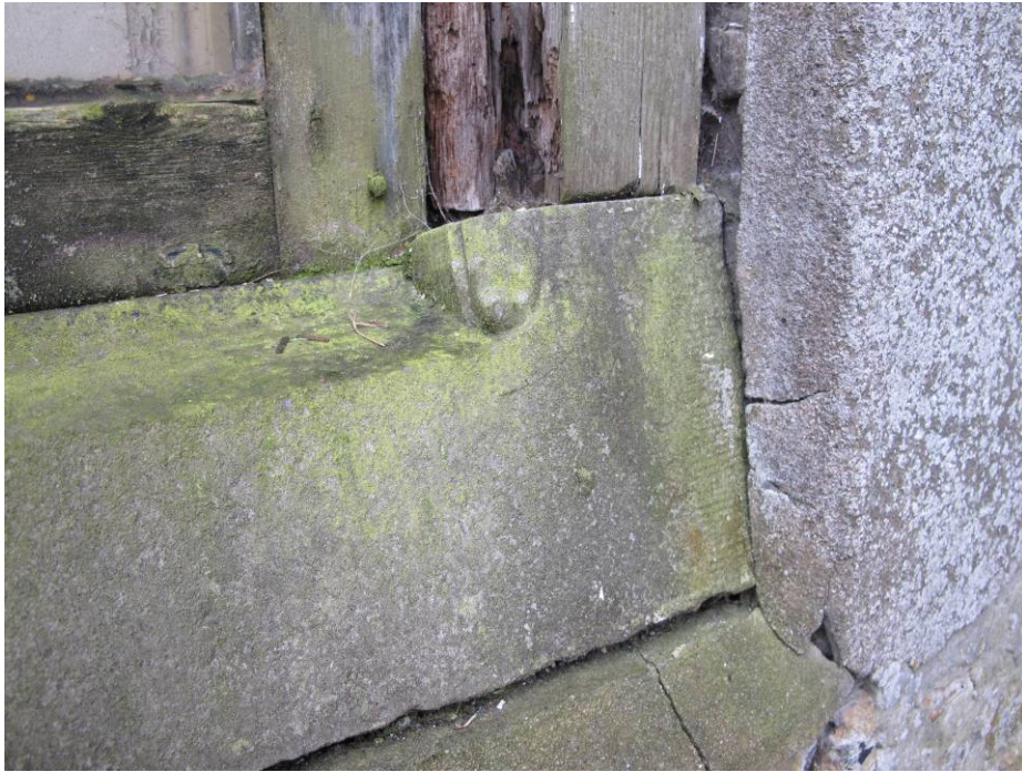
Detail van de fraai bewerkte hardstenen dorpel onder de vensters.
