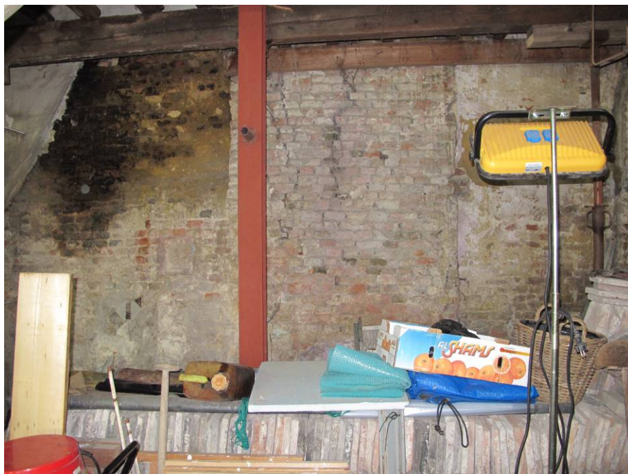
Overzicht van de achtergevel, met links de aftekening van een vroegere stookplaats.
