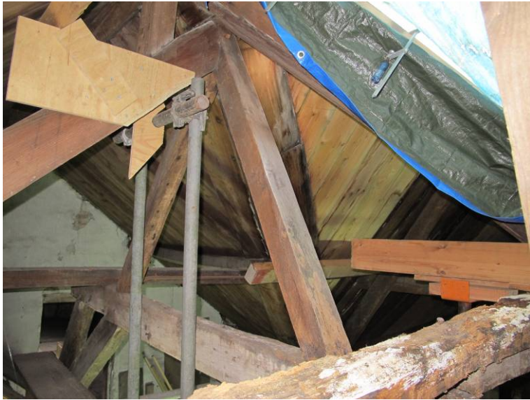
Stapeljuk op het afwijkende voorste dekbalkjuk.
