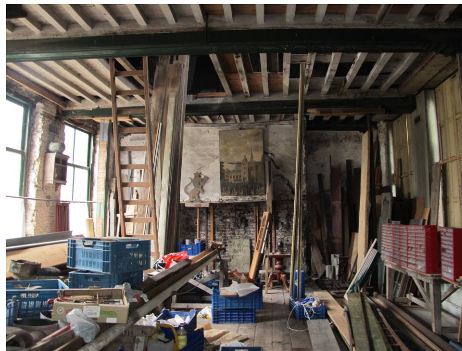
Overzicht balklaag zuidelijk bouwdeel, gezien richting zuidgevel.
