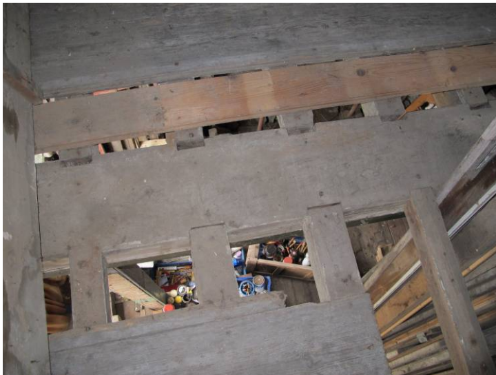
Bovenzijde van één van de moerbalken en de aansluiting van de kinderbinten.
