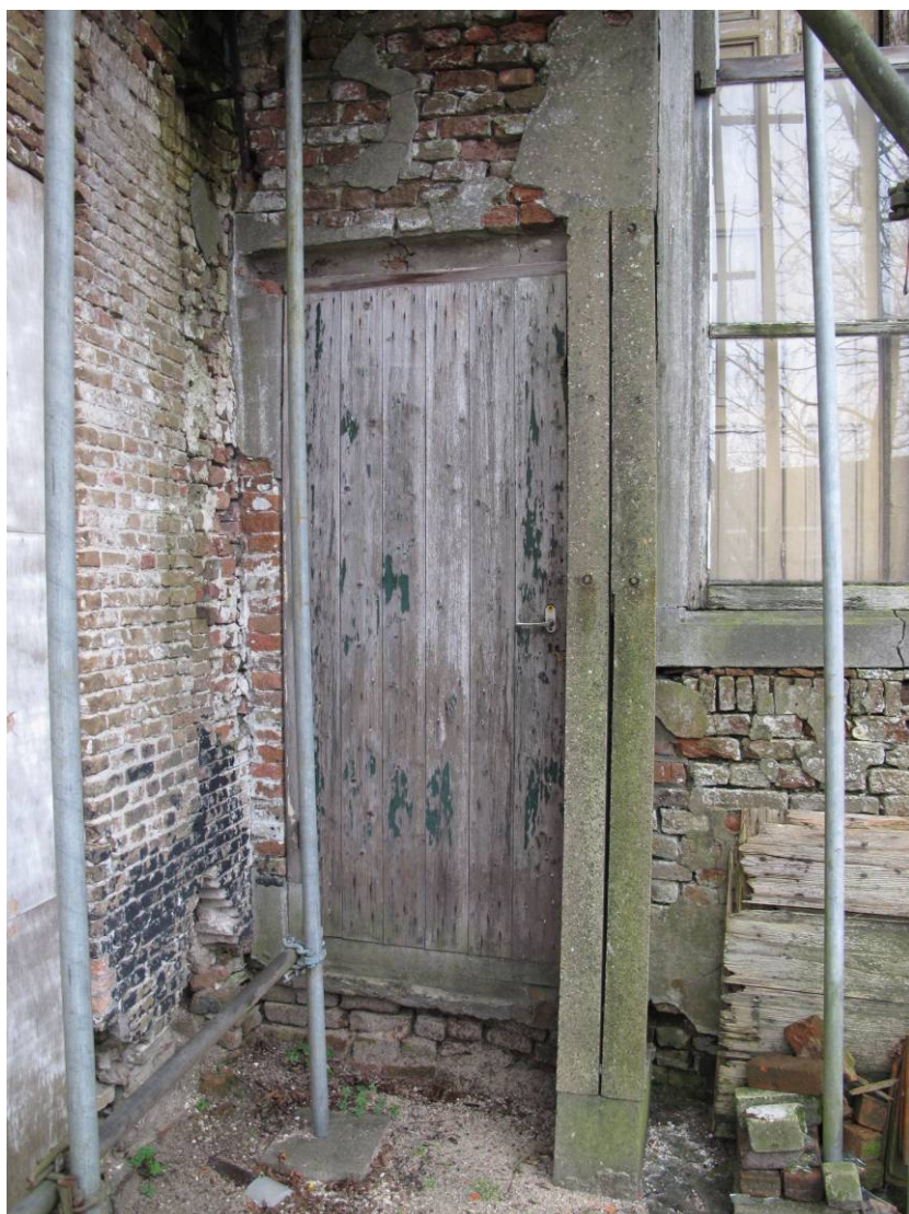
Detail later ingevoegde deuropening, direct naast het noordelijke bouwdeel.
