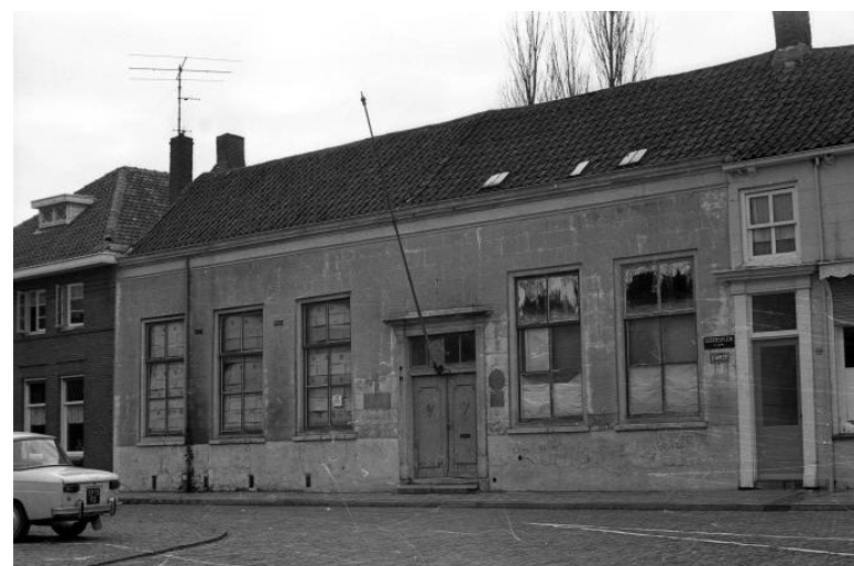
Foto uit 1970, waarop te zien is dat de vensters zijn afgeplaat. Bron: Beeldbank Zeeuwse Bibliotheek.
