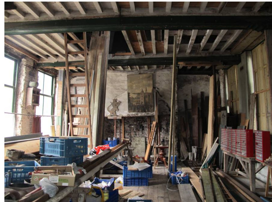
Overzicht begane grond zuidelijk bouwdeel, gezien richting zuidgevel.
