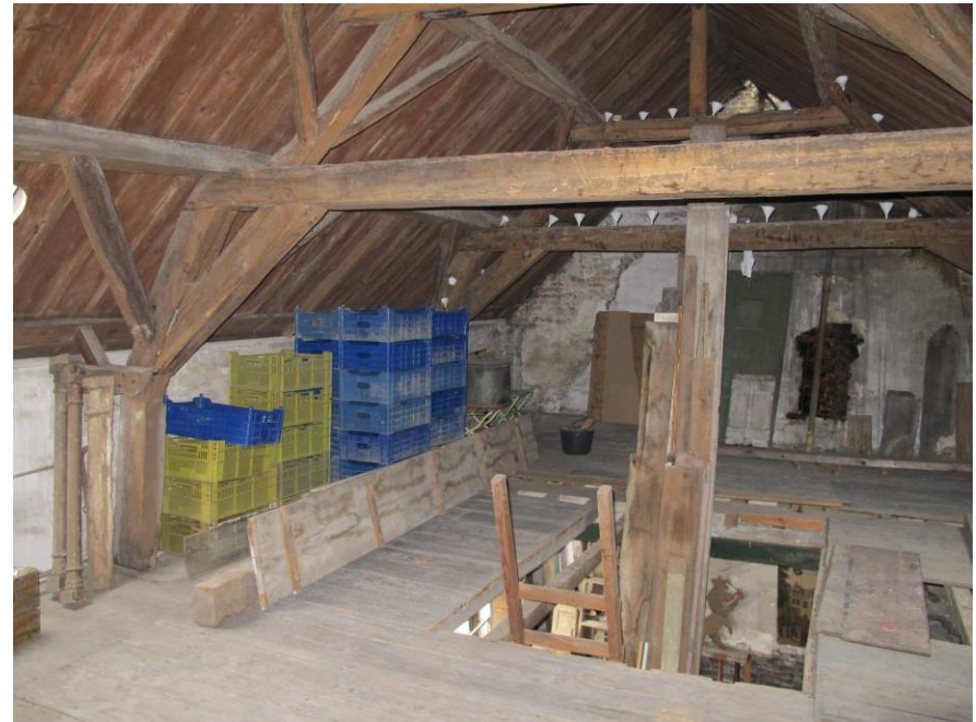
Overzicht kapconstructie zuidelijk deel, gezien richting zuidgevel.
