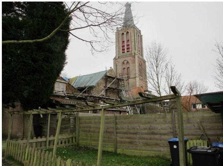
Zicht vanaf de Lewestraat op de achtergevel van Geertesplein 21.
