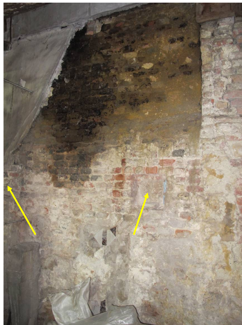
Detail van de stookplaats met hieronder zichtbare ondiepe nisjes.
