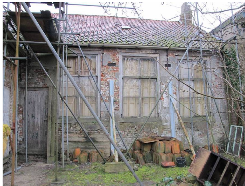
Overzicht van de achtergevel van het zuidelijke bouwdeel.
