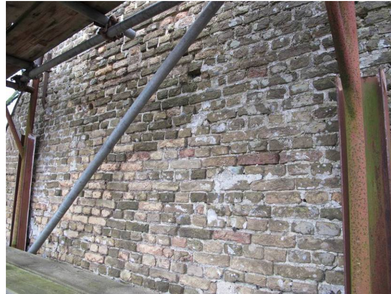
Het metselwerk van het bovenste deel van de achtergevel is duidelijk veel meer samenhangend dan het onderliggende werk.
