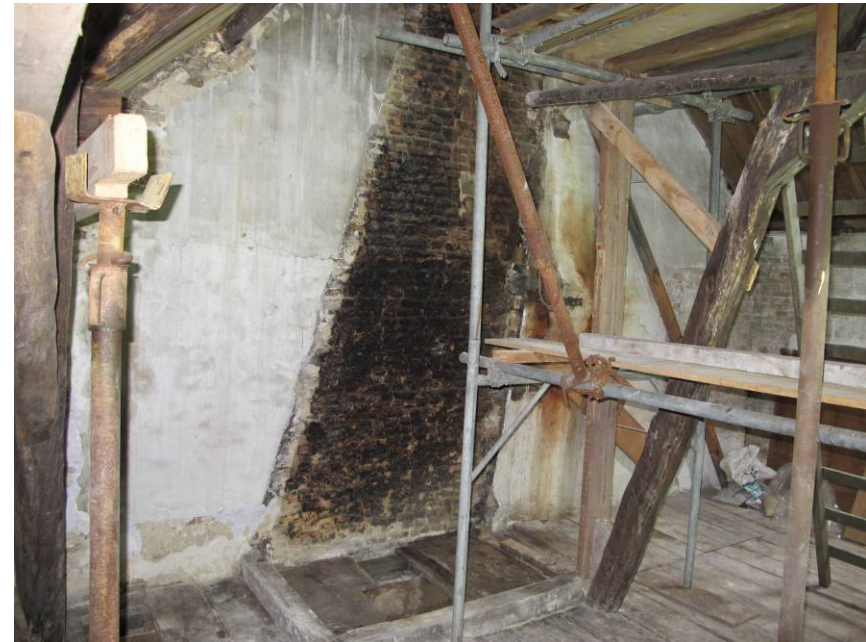
Overzicht verwijderd rookkanaal tegen noordgevel.
