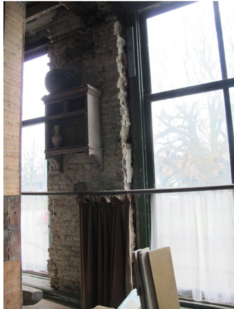
Behakte dagkanten van de vensters in de voorgevel van het zuidelijke bouwdeel.
