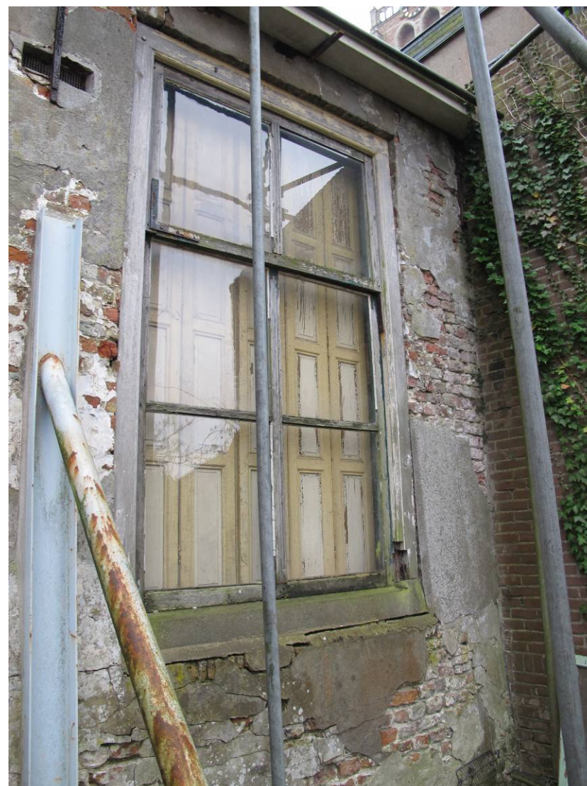
Overzicht van één van de 18 de -eeuwse vensters in de achtergevel.
