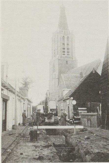
Rioleringswerk in de Jachthuisstraat
