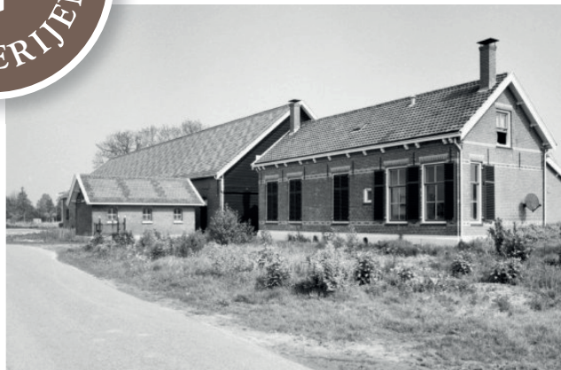
De Elshoeve uit 1895 in 's-Heer Elsdorp, de huidige Stelleweg (foto 2002)
