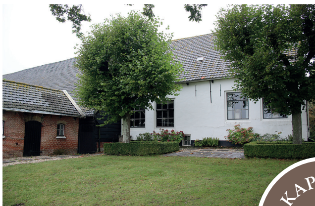
Hof Welgelegen aan het Pykeswegje (1674), jaartalankers aan de voorkant van het woonhuis
