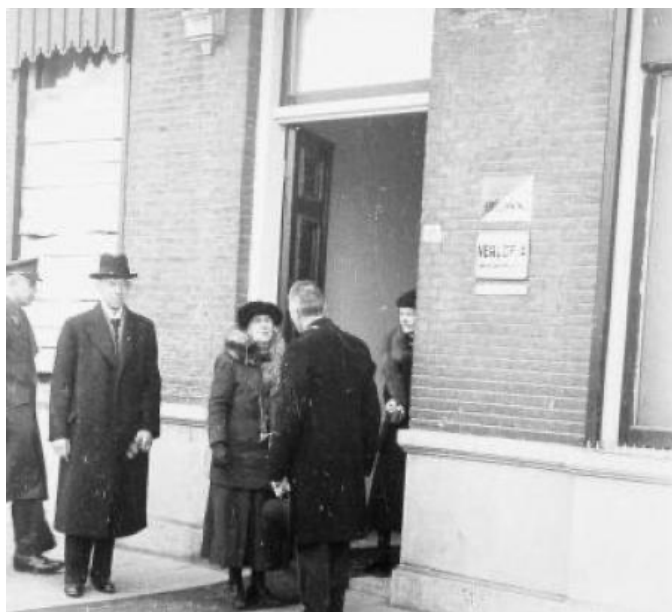
Koningin Wilhelmina voor Loskade 45 te Middelburg in de 2de Wereldoorlog (Hotel De Burg)
